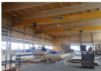
Die beiden Brückenkranen weisen jeweils 6,3 Tonnen Tragkraft auf.
