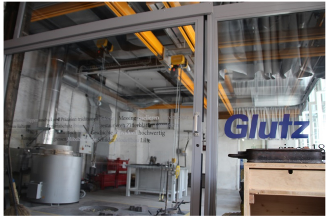
Einschienebahn und Zweiträger-Systemkran
