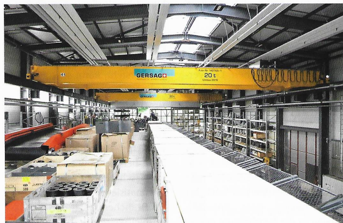
Die dritte Arbeitsebene ist leicht zugänglich mit den Zweiträger Brückenkrane.
