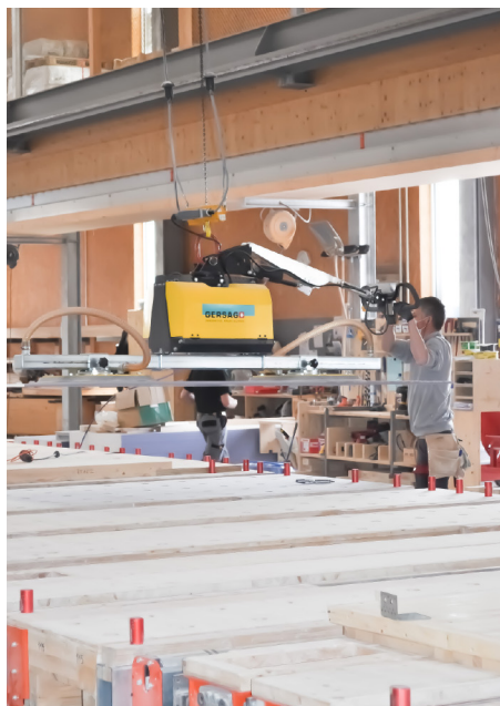
Der Kran wird vom Boden aus bedient.
